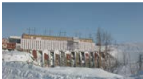
БалГЭМ продолжает работы на энергообъектах Норильска → стр. 5
